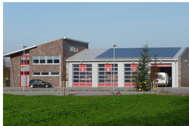
Feuerwehrhaus-Rindern; seit 2010 (24,05 kW peak)
