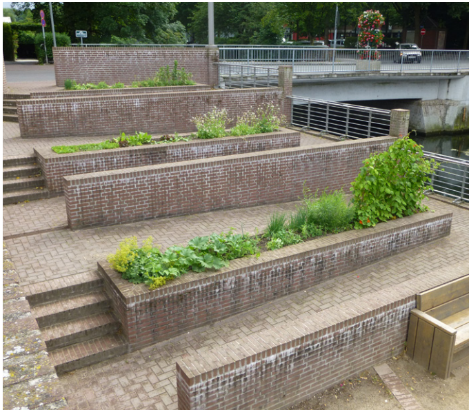
Das Bild zeigt die vorhandene Rampenanlage am Opschlag. Durch die Anbringung von Handläufen und einer kontrastreichen Markierung der Trittstufen könnte die Barrierefreiheit verbessert werden.
