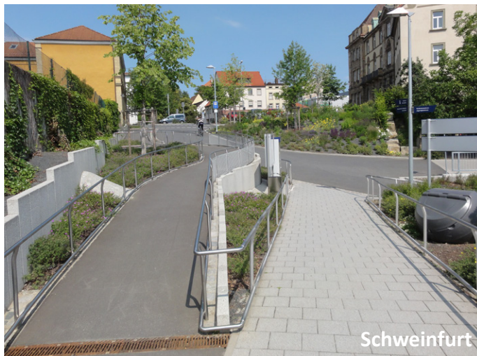
Das Bild stammt aus der Stadt Schweinfurt. Hier wurde eine Lösung entwickelt, die sich in den städtebaulichen Kontext gekonnt integriert.
