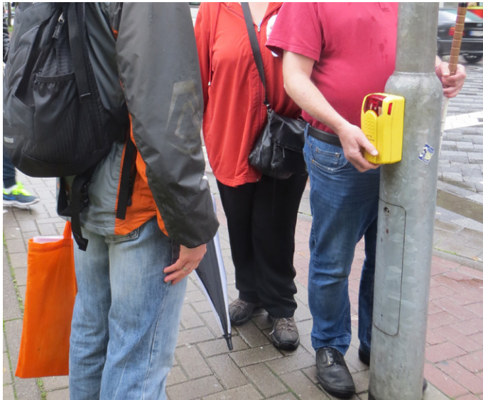
Das Bild zeigt die vorhandene Lichtsignalanlage am Bahnhof sowie die Nutzung des taktilen Signalgebers an der Unterseite des Anforderungsgerätes.
