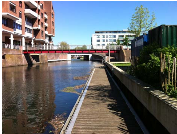
Bootsanlegestelle am Opschlag (Foto: REFLEX architects_urbanists)
