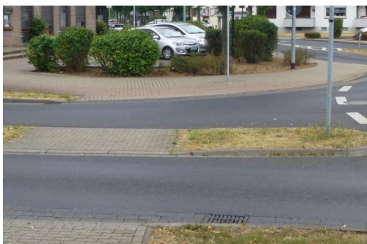
Abbildung 22: Fehlendes Leitsystem am Kreisverkehr
