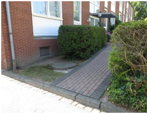
Abbildung 25: Erschwerte Gebäudezuwegung durch hohe Kante (Großer Heideberg)
